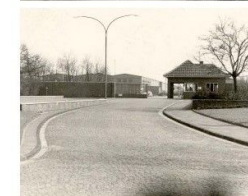
Hauptzufahrt zum Babcockgelände in Friedrichsfeld, Spellener Straße
